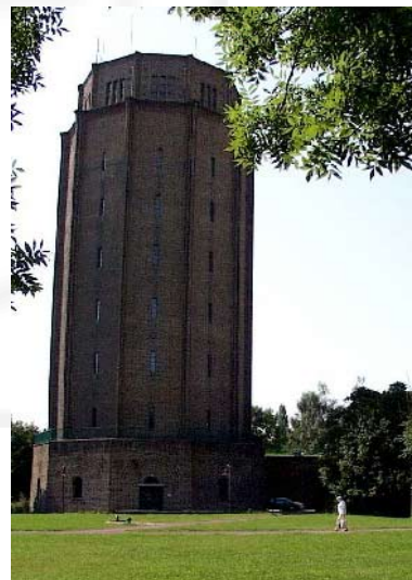
der nahegelegene Wasserturm Süd
