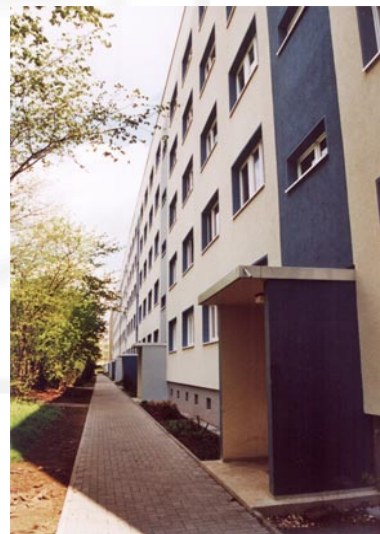
Eingang vom Hof
